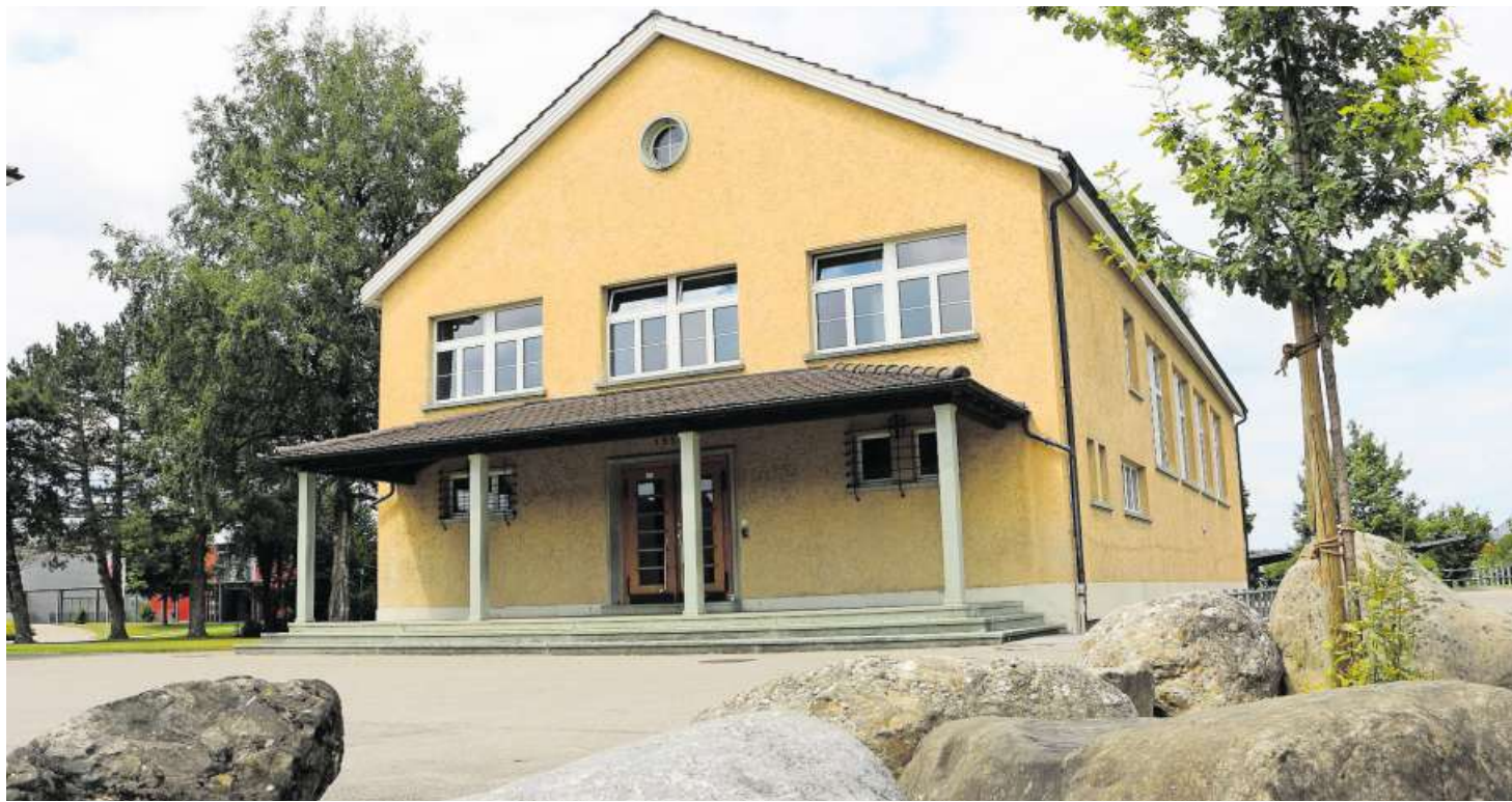
Der Raumbedarf für die Tagesstruktur soll in die vorgesehene Sanierung der alten Turnhalle (im Bild) einfließen.
